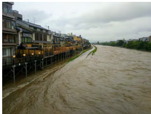
平成30年7月豪雨の際の鴨川沿いの様子(京都府京都市)
