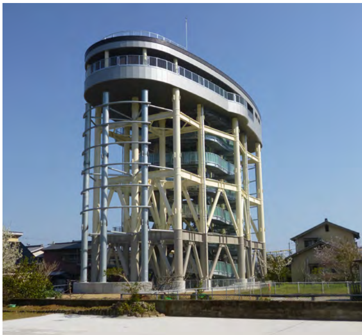
高知県黒潮町の津波避難タワー
