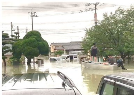
図1 令和2年7月豪雨における本校浸水状況
